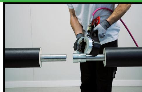
Presskopf anbringen und dabei kontrollieren, dass die Verbindung nicht vom Rohr geschoben wird....
