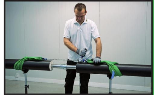
Bei größeren Rohren oder bei Arbeiten in Schräglagen empfiehlt es sich einen Seilzug zum Zusammenbau der Rohre bzw. zur Sicherung der Lage zu verwenden. Die Rohre müssen beim Zusammenfügen absolut fluchtend sein. Die Rohre dürfen erst nach der Verpressung gebogen werden.
