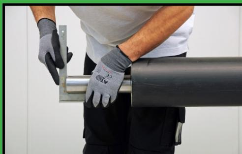
Falls die werksseitig vorgedämmten Rohre auf der Baustelle geschnitten werden, muss der Schaum auf einer Länge von 150-200mm entfernt werden und es ist zu überprüfen, dass die Schnittfläche des Stahlrohres gerade und rechtwinkelig zum Rohr ist.
