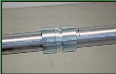
Nachdem das zweite Rohr positioniert ist, ist ebenfalls eine Markierung zu setzen.
