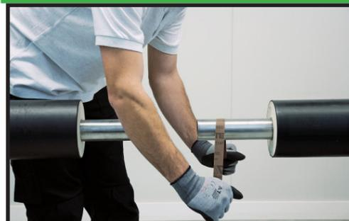
Die Rohre müssen sauber, frei von Rost und Fett sein. Falls es notwendig ist, sind die Rohrenden mit einem Schmirgelleinen zu überarbeiten. Tiefe Riefen und Kerben auf der Stahlrohraußenseite sind zu entfernen.
