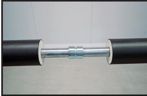
Das zweite Rohr ebenfalls säubern bzw. vorbereiten - siehe Schritte 03-05 dieser Anweisung - und bis auf Anschlag in die Verbindung schieben.
