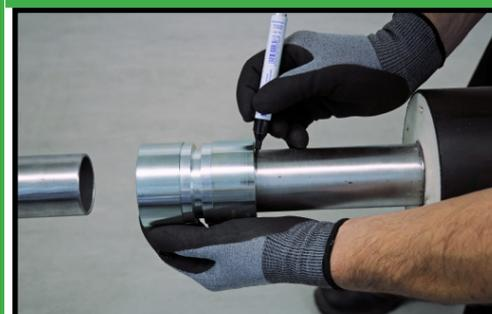
Das Verbindungsstück bis auf Anschlag auf das Rohr schieben und die Position markieren.
